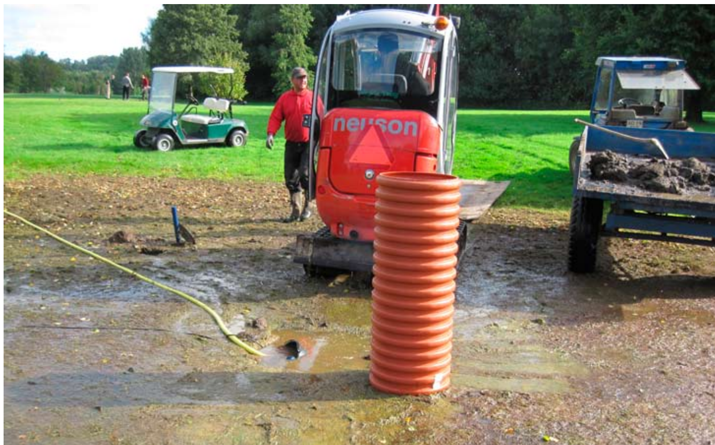
Pumpebrønd på 18. hul. Som det kan ses på billederne er der sket en del skader på græsset fordi det har stået under vand. Græsset skal luftes og strigles så der igen kan komme liv i det.
